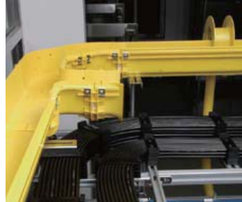
光纤槽道水平三通出口
