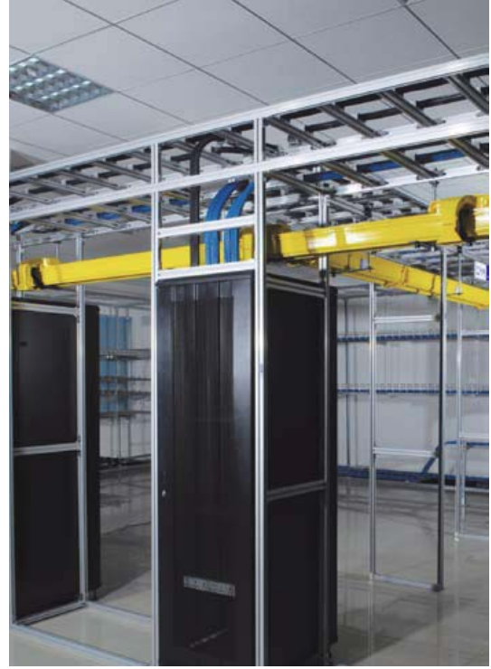
地面支撑安装方式
